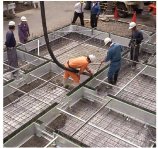
底盤と同時に立ち上がりを打設している
