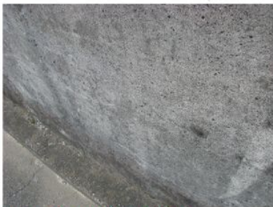
古いコンクリート基礎
