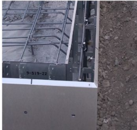
ド真ん中に配筋される
